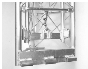
Mastfuß mit Kippscharnier; darüber Seil-Aufhängung und Gleitführung
