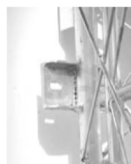
Verschraubung Kipp- zu Hilfsmast
