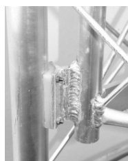
Gleitführung am Ende des Mastsegmentes
