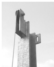
Umlenkrolle oben am Hilfsmast
